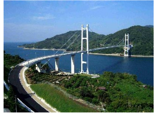
【豊島大橋（愛称：アビ大橋）】
